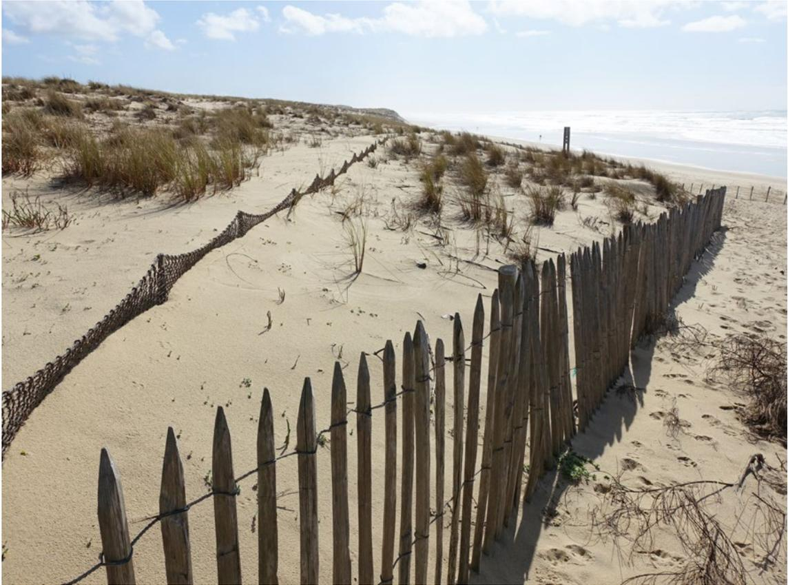
*Brise-vents et ganivelles aident à capter le sable transporté par le vent sur les plages de la côte aquitaine. La plantation d'espèces végétales halophiles permet la fixation des dunes, freinant ainsi l'érosion côtière.*
