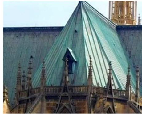
Figure 35 : Cathédrale de Metz et sa toiture en cuivre
