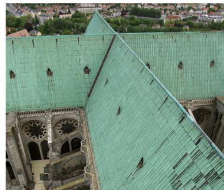
Figure 36 : Cathédrale de Chartres et sa toiture en cuivre (avant restauration)
