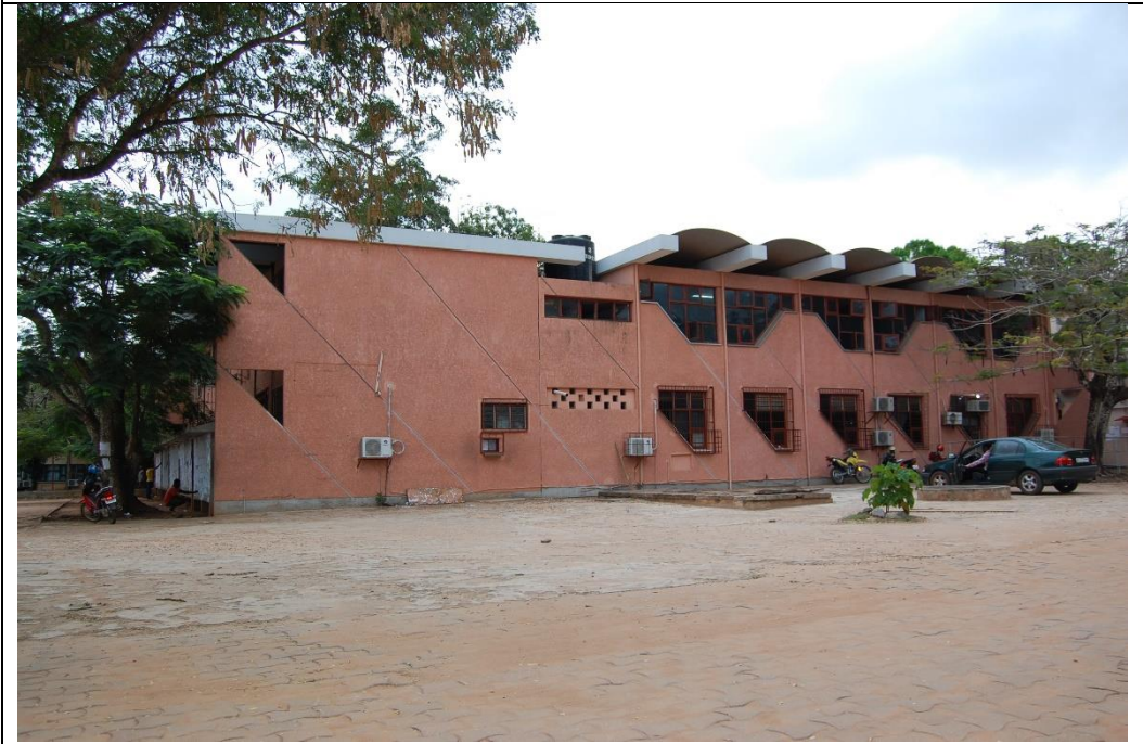
Source : Serge Attènoukon, Chef-Service Communication Rectorat UAC, 2016 (Construction FAC, 1972)
