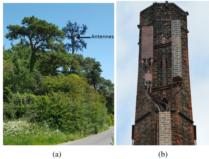
FIGURE 1.30 : Antennes de station de base intégrées et cachées dans leur environnement : (a) site rural, (b) site urbain
