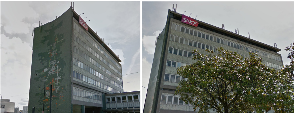
FIGURE 1.25 : Exemple d'un site multi-opérateurs sur la gare de Nantes
