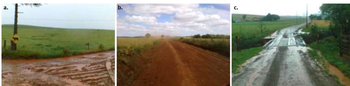
**Figure 6.1. Importance des routes dans comme source de particules. (a) Route endommagée par le passage de machines agricoles, (b) tassement d'une route et (c) mise en évidence du ruissellement le long d'une route (Photographies, T. Tiecher).**
