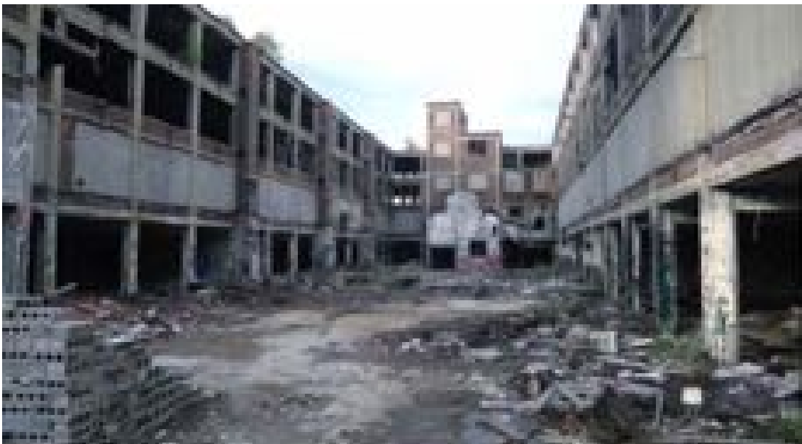
Figure 25 - Packard Automotive Plant, East Side grand Boulevard, Concord Street, Détroit. Crédit : François Huguet, 2013.
