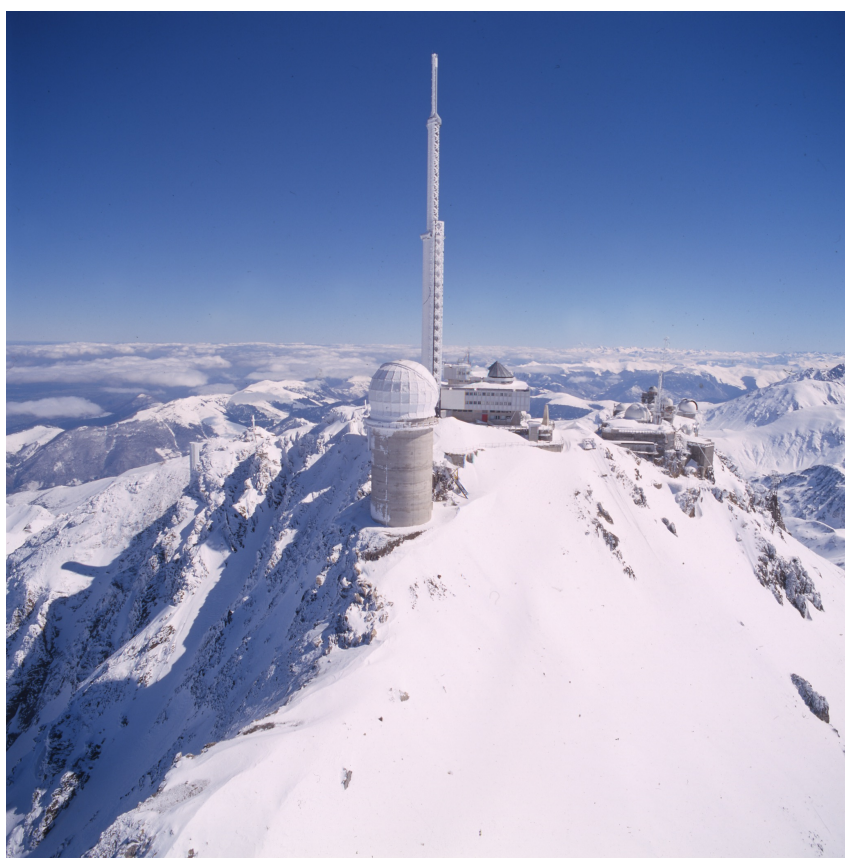
Document 16. Le bâtiment du télescope Bernard Lyot et l'antenne TDF.
