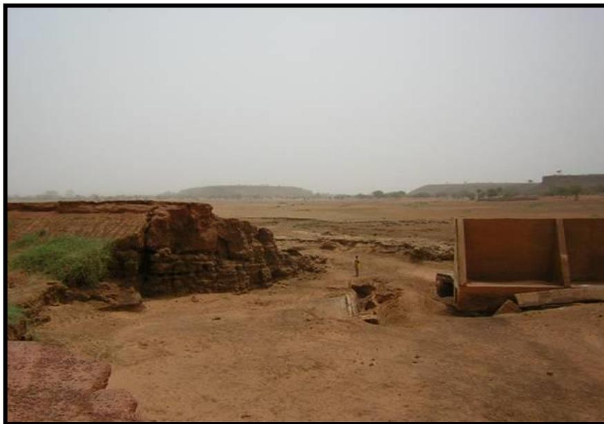
**Figure I-2: Rupture de la digue du barrage de Bani au Burkina Faso. Photo : H. Karambiri.**
