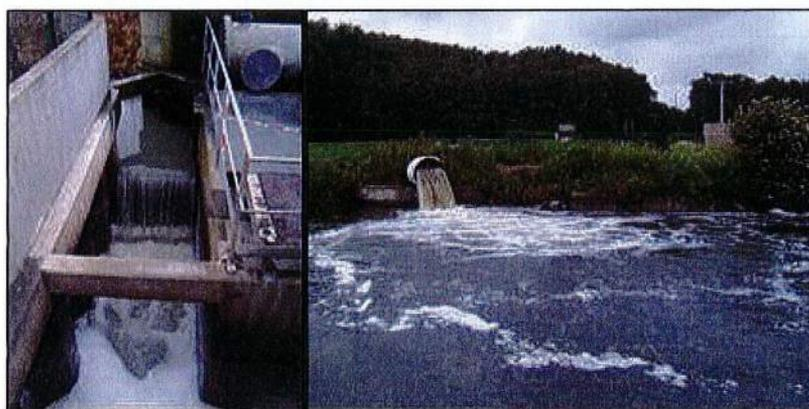
**Figure 2. 4 : Station de relevage « Vallée de Scarpe ». A gauche : arrivée des eaux dans la station. A droite : rejet dans la Scarpe Inférieure.**
