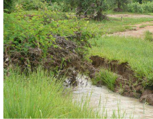
Photo 62 : Portion de berge arrachée par la puissance de l'écoulement
