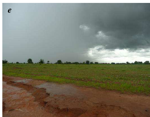
e : Bordure de fossé attaqué par l'eau
