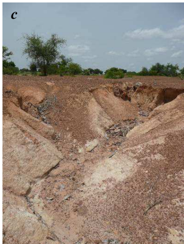
c : Mise en évidence de l'érosion régressive Dépôts de brindilles issues des écoulements de versant
