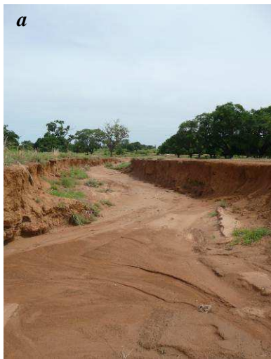
a : Secteur aval du ravin Très large et moins profond (1,50 m)
