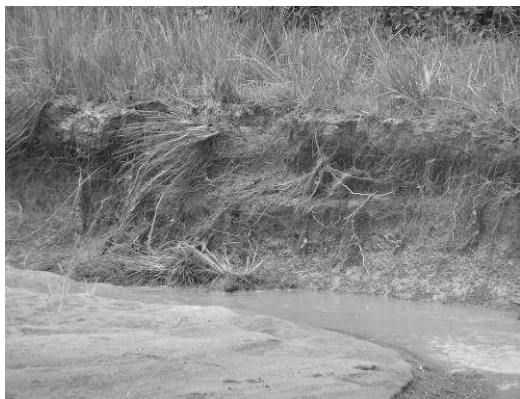
Photo 80 : Berge érodée au site de Bassaré
