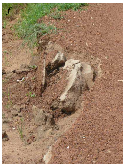
f : Blocs dissociés de la piste par l'érosion hydrique
