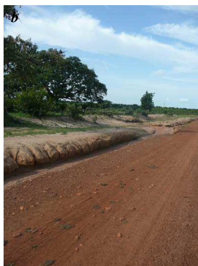
b : Bordure de fossé présentant des rigoles
