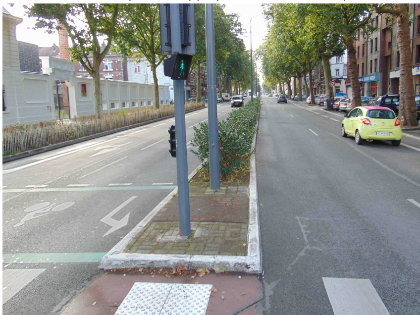
Illustration 50. Buissons épineux au centre du boulevard Montebello à Lille et palissade latérale pour empêcher les cheminements piétons en ligne droite vers l'entrée du collège de Wazemmes (à gauche) et les canaliser vers les passages piétons protégés, renoncement aux principes d'un espace ouvert et lisible (Photo L'Hostis 2014)
