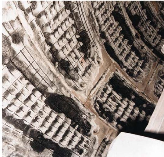
*Figure I. 2 : Dégâts observés après l'incendie dans le tunnel sous la Manche*
