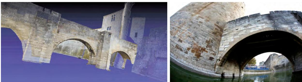
Figure 15 - Modélisation du pont de la tour de Constance à Aigues-Mortes (Gard) à partir de photos acquises depuis une barque ; à droite une des photos acquises.
