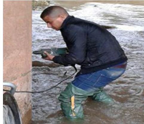
Photo 6 : Installation d'une échelle limnimétrique sur le pont de l'Oued Ouzoud (Benchattou, 2019).
