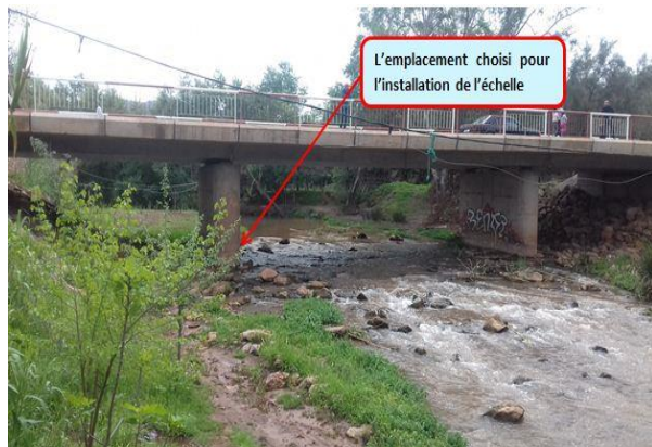
Photo 5 : Le choix de la section pour installer une échelle limnimétrique (BENCHATTOU, 2019).
