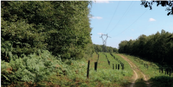
Figure 1. Ligne électrique THT en tranchée forestière, aménagée en verger pour la faune sauvage (49.8787 N, 4.6800 E).
