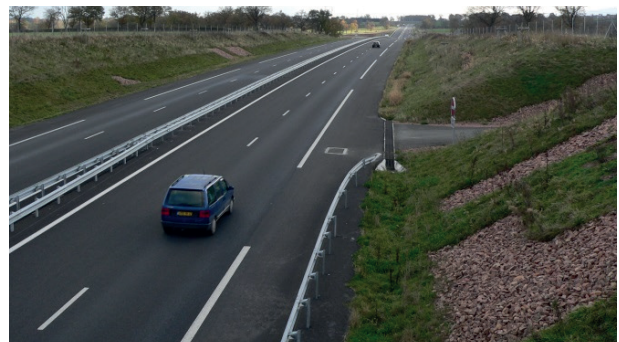
Figure 4. Route à deux chaussées : bande de proximité récemment tondue (46.1915 N, 3.8897 E).
