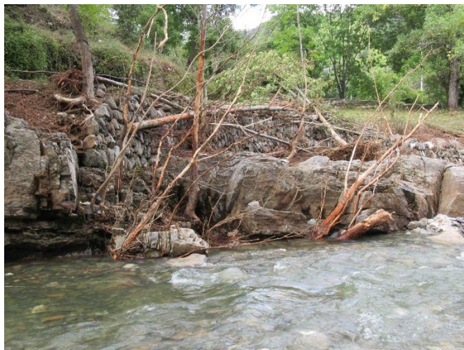
FIG.8 — STATION DE SAUMANE SUR LA BORGNE ; ANCIEN EMPLACEMENT DU SOLOPHÈME EN RIVE GAUCHE ; LE BOITIER ÉTAIT DANS UN ARBRE QUI A DISPARU
