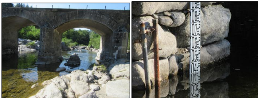
FIG.55 — STATION DE SAINT-JEAN DU GARD — À GAUCHE, GARDON DE SAINT-JEAN AU PONT DE CAMBONÉRAL, VU DE L'AMONT — À DROITE, ÉCHELLE AU PLUS BAS DE L'ÉTIAGE, LE 9 SEPTEMBRE 2019
