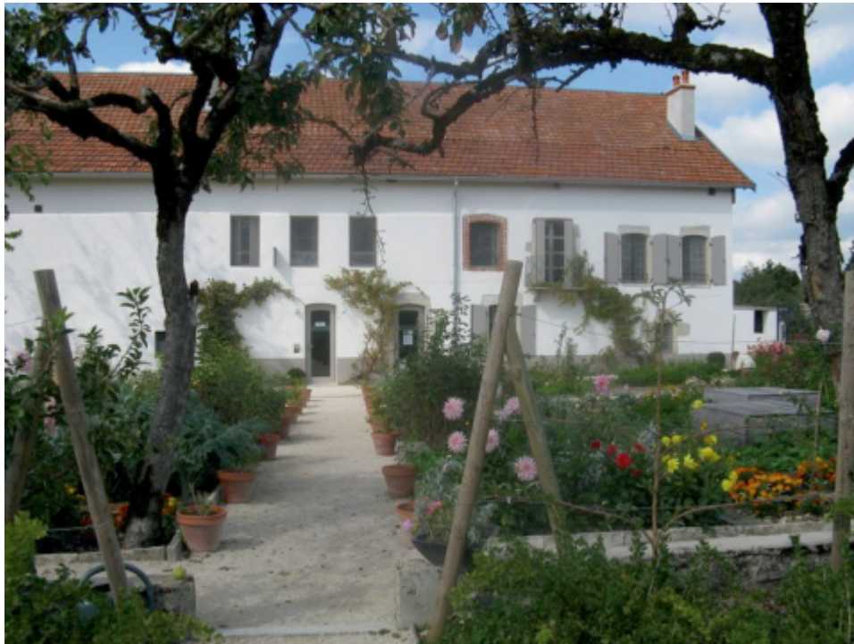
Figure 2. La Ferme Courbet réhabilitée.
