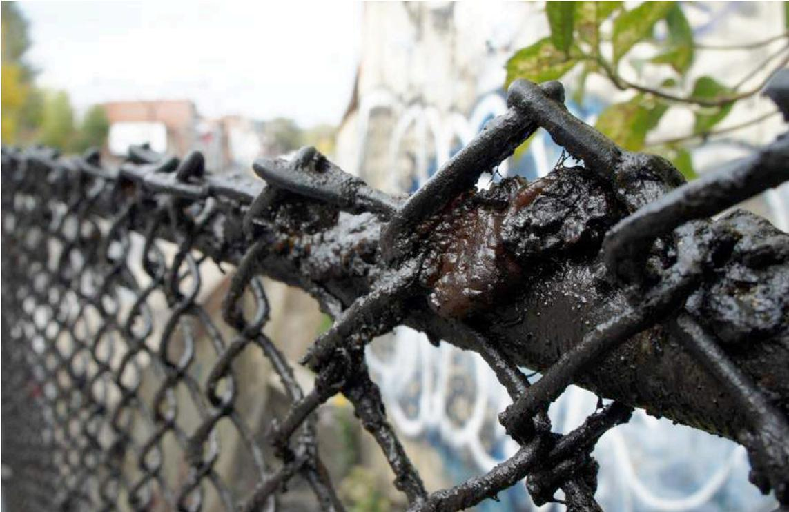
Section de clôture enduite de graisse pour empêcher les passants de sauter par-dessus.
