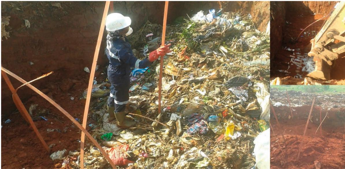
Figure 2. Remplissage du casier
