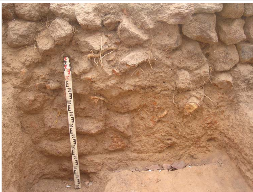
C. Base du mur du vestibule côté Est à plus de 1m de profondeur ; elle a été aussi aménagée avec des grosses pierres ; on ne remarque pas la présence de semelle
