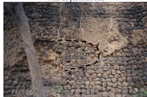
Zone réparée, sur la façade Sud du rempart, identifiable par une discontinuité de la maçonnerie et des moellons de taille réduite
