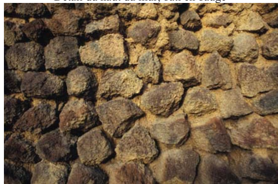
Détail de la maçonnerie de pierre
