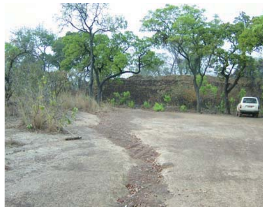
Ecoulement des eaux à proximité des ruines
