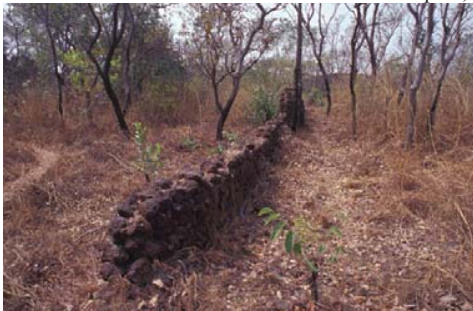
Mur de partition nord
