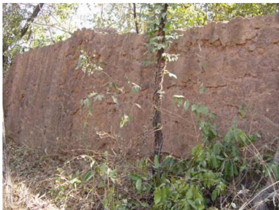
Photo n° 53 : Ruine de Bini mur crépi
