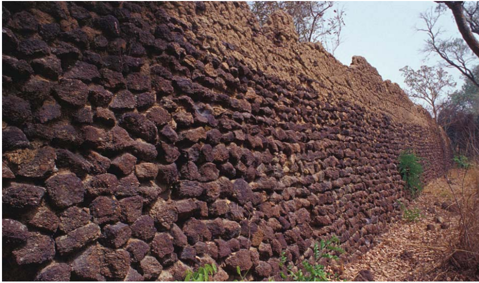
Mur d'enceinte en pierre couronnée de bauge
