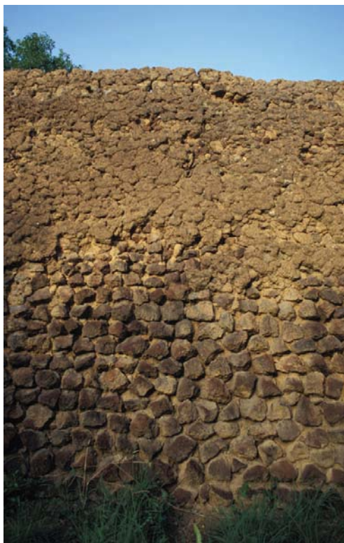
Vue d'ensemble sur un mur type
