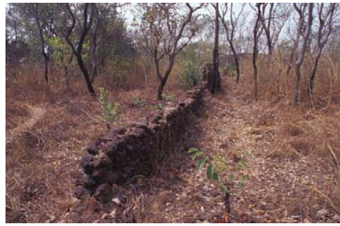
Mur de partition nord
