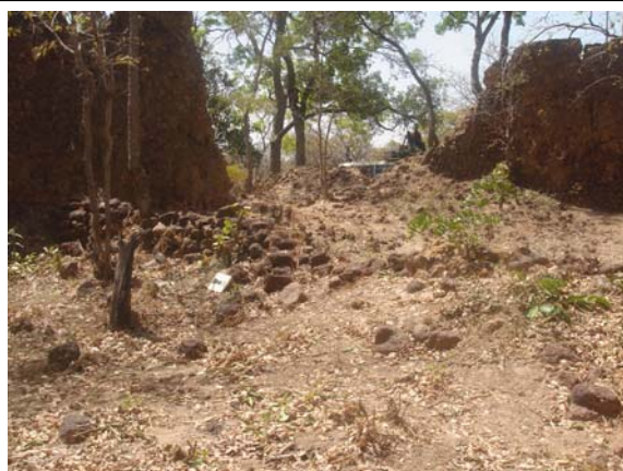
D. Eboulement au niveau du mur de partition
