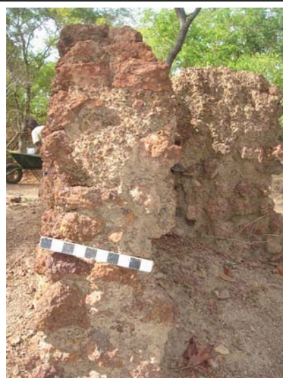
D. Détail sur l'épaisseur des murs.
