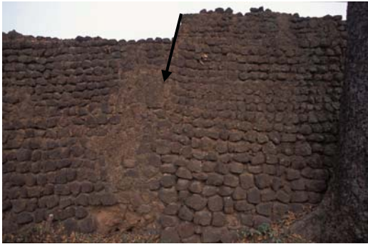
La discontinuité dans la maçonnerie de la partie Nord du rempart Est semble indiquer que cette partie de mur a été reconstruite
