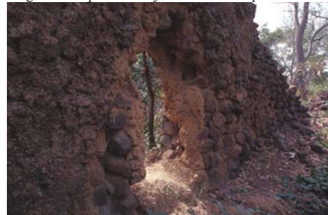
Mur de partition sud
