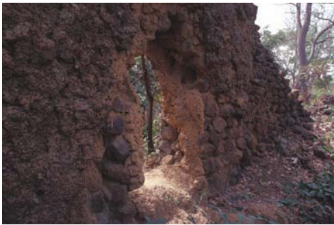
Mur de partition sud, avec vue sur ouverture
