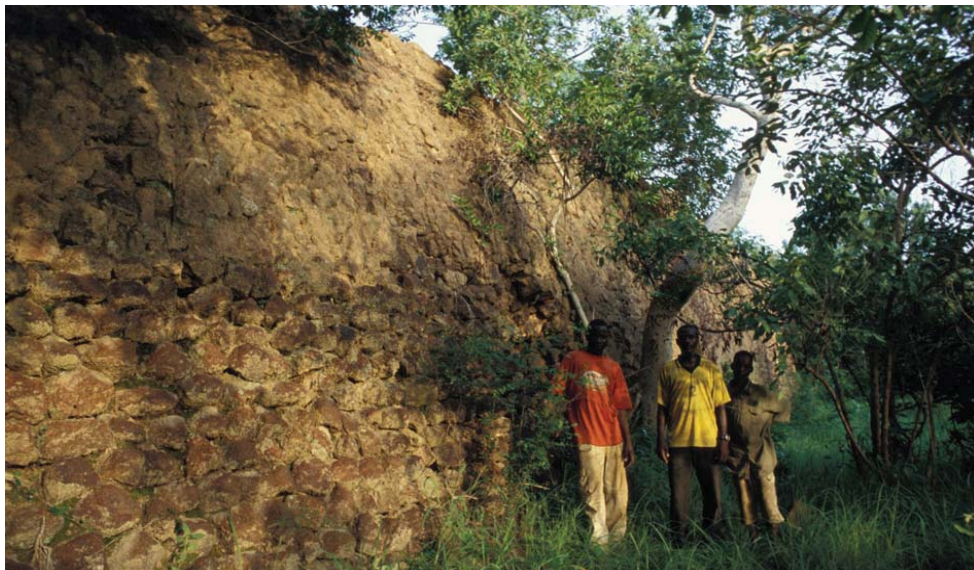
Façade Ouest du rempart principal
