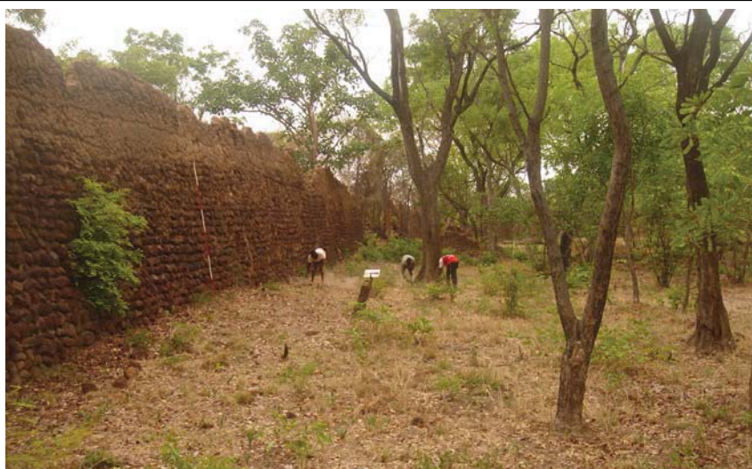
E. nettoyage au secteur 10, le long de la muraille
