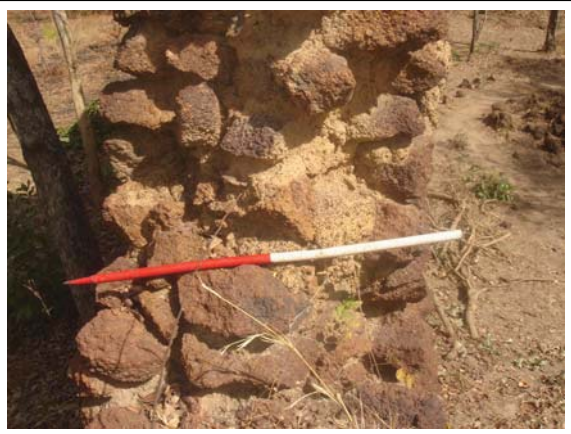
F. Vue de l'épaisseur de la muraille (1m). On distingue entre les pierres le liant en argile
