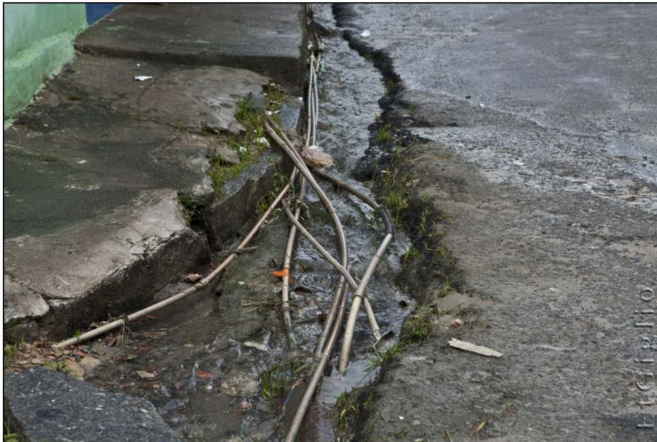
Photo 1. Branchements clandestins d'eau courant le long du caniveau à Ibura
