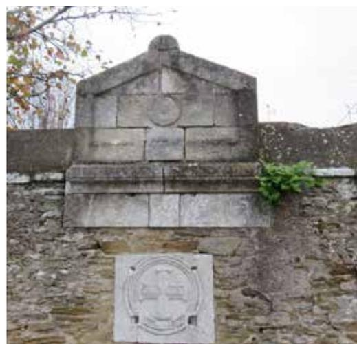
Meulière taillée, appareil régulier allongé pour le portail et hexagonal pour les murs, sur un soubassement de pierre taillée pour le portail et de moellons enduits, cimetière d'Enghien-les-Bains (Val-d'Oise).
