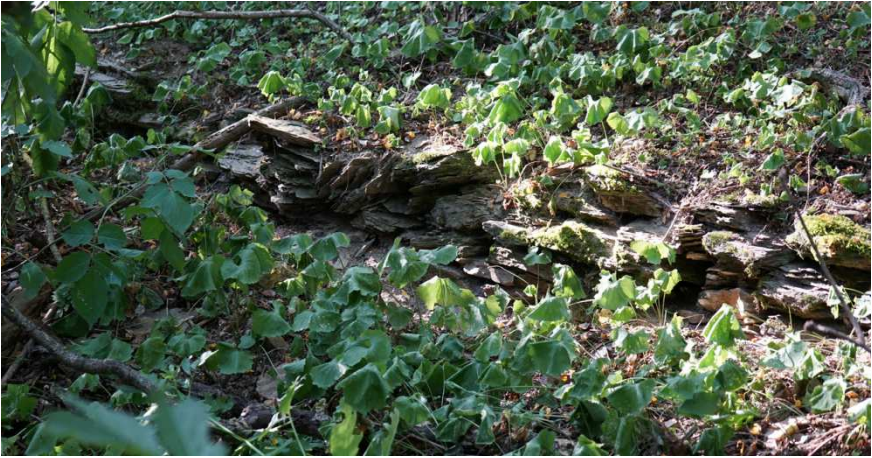
Abb. 10 Mendig, „Im Terl“. Weinbergsterrassenmauer bei Punkt 2 auf Abb. 8. (24.7.2019).
