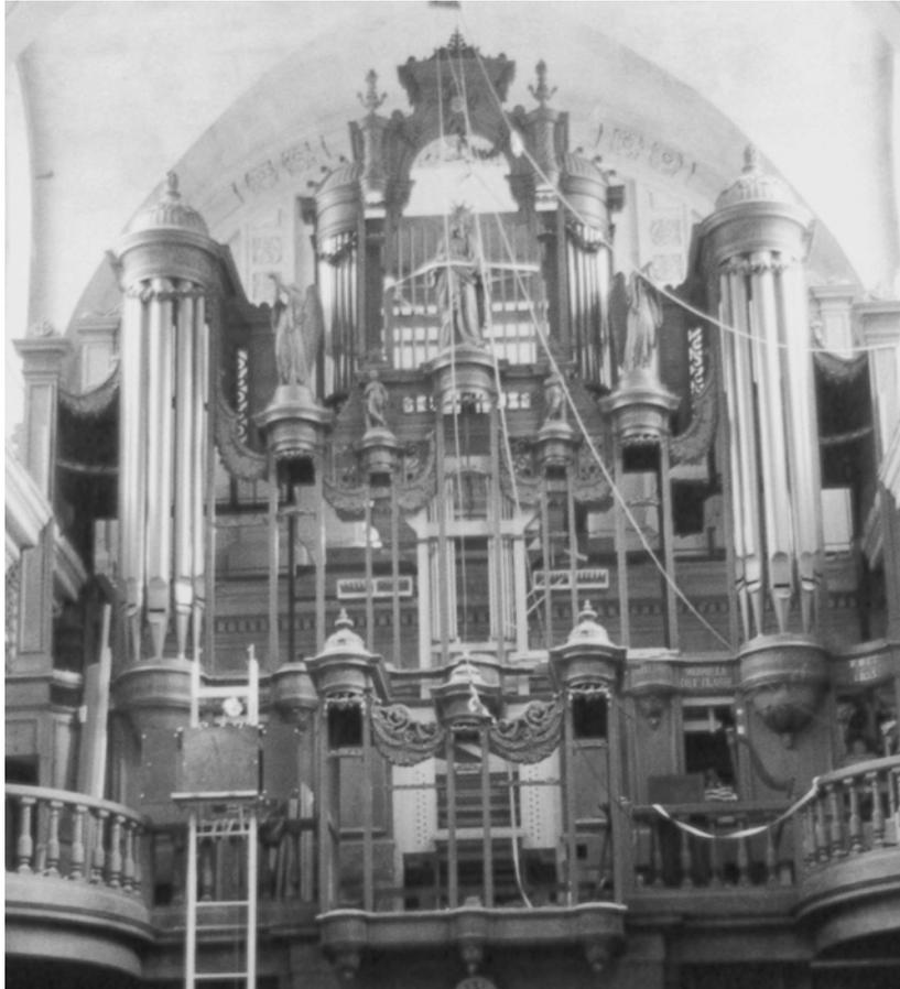
**Figure 70: remontage de l'orgue restauré par Michel Giroud. Vue générale du buffet. On aperçoit la boîte du Récit et les pièces gravées du Grand Cornet.**
