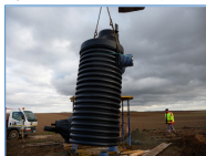
Fig 1. Installation d'un tube PEHD après excavation (Nov. 2012)
