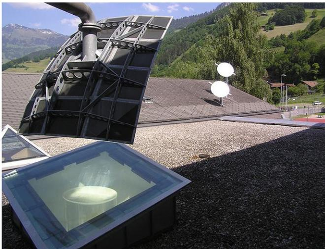
▲ Capteur de conduit de lumière prismatique. Héliobus.
