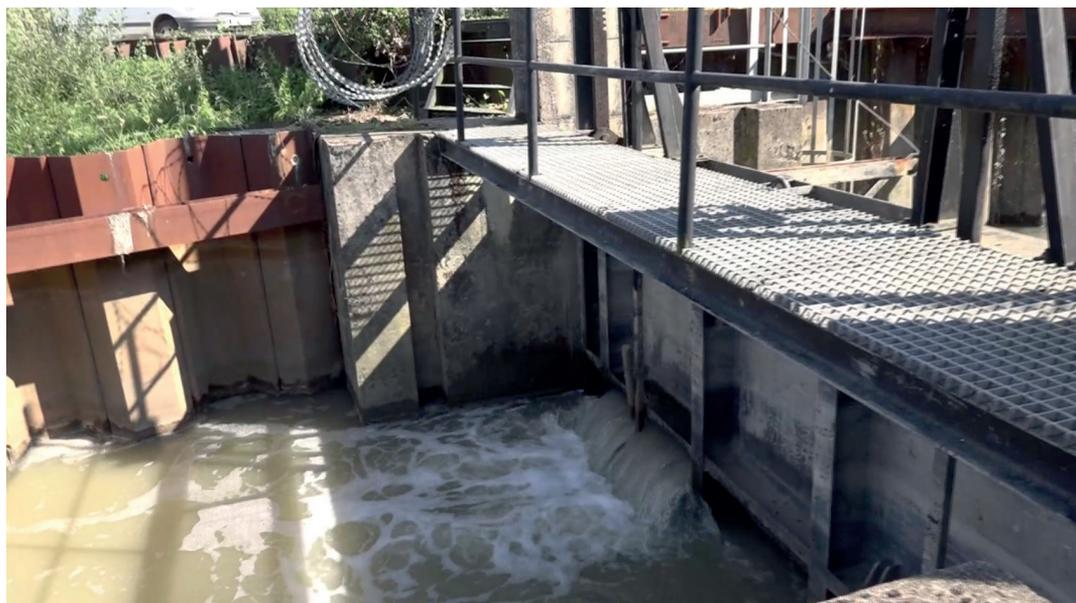
**Fig. 7** Une vantelle ouverte sur la vanne de Cordemais permet, depuis l'estuaire, à la marée et aux sédiments de venir nourrir le marais du Lot en amont, une cale de bois posée par l'éclusier garde une ouverture permanente pour « tenir le niveau », et permet en même temps le passage des poissons.
