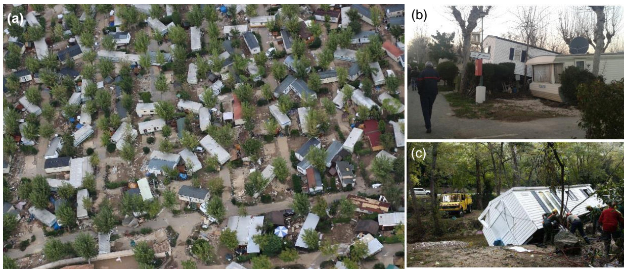
Figure 27 : Effets de la flottaison sur (a) les mobile homes d'un camping lors des événements de La Brague en Juin 2013 en France (Photos credits : RTM/Irstea), et (b-c) les mobile homes au Canada lors de l'événement à Cougar Creek, Alberta en 2013 (Photos credits : BGC ENGINEERING INC.).
