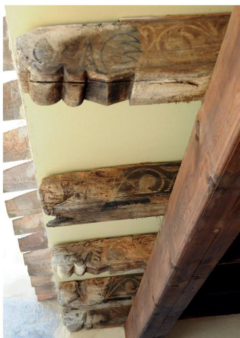
Fig. 4 : Des solives moulurées en remploi dans un auvent (Photo : J.-P. Sarret)
