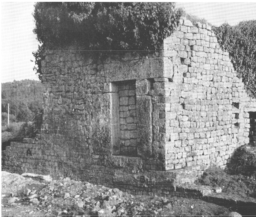
Fig. 12. — Face nord de la chapelle. A : mur d'enceinte nord ; B : seuil de porte antique.
