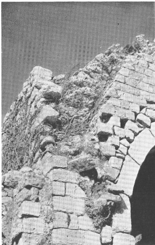
Fig. 9. — Face sud de la *cella*: moellons taillés suivant la courbe de l'intrados de la voûte.
