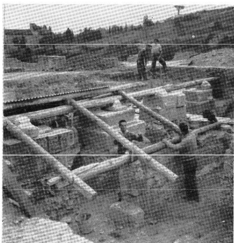
Fig. 7. - - Les piliers de fondation élevés dans les ruines de la maison XVIII et recouverts par le dallage de la cour à portiques.
