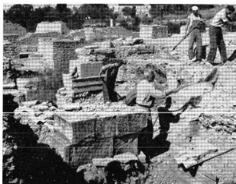
Fig. 8. — Maison XVIII. Dégagement des premiers piliers de fondation, faits de matériaux de remploi provenant de Glanum I .
