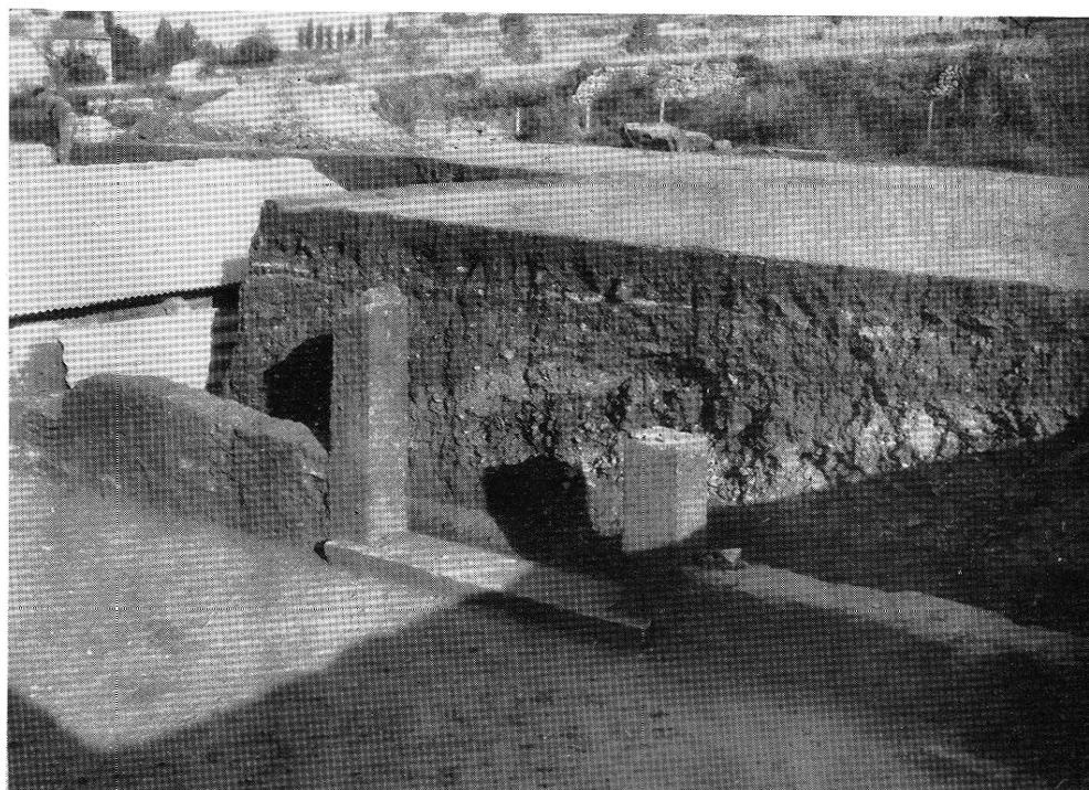
Fig. 15. — Maison XVIII. Porte Est de la cour avec seuil monolithe. Dans l'épaisseur du remblai on distingue les apports constituant une stratigraphie artificielle.
