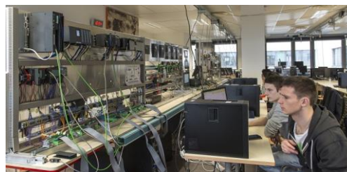
Fig 1. Vue partielle de la plateforme G-ICS
