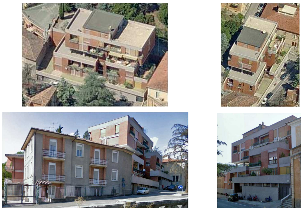
Exemple d'irrégularité en élévation avec possible formation d'étage souple. Séisme de L'Aquila 2009. Hôpital de L'Aquila
