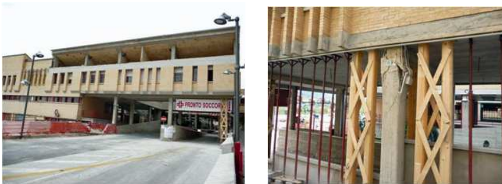
Exemple d'irrégularité en élévation avec possible formation d'étage souple. Séisme de L'Aquila 2009. Hôpital de L'Aquila
