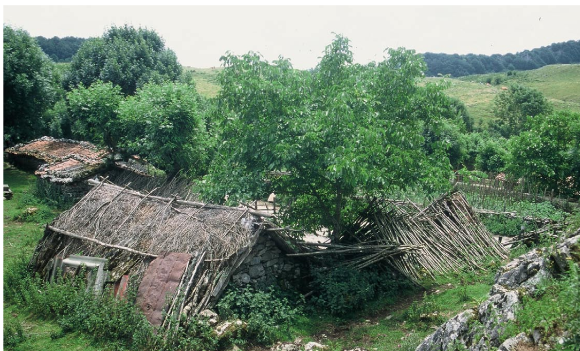
Fig. 19 : Cabanes avec toitures végétales et de tuile dans un ensemble pastoral de la Sierra de Aralar en Guipuzcoa (photo Pierre Campmajo). D'après l'ethnologue Fermin Leizaola, les ordonnances des pâturages communaux ont, jusqu'en 1936, interdit de couvrir les cabanes en tuiles, celles-ci étant considérées comme symbole d'appropriation (Leizaola Calvo et Montero Arrucaeta, 1999, p. 92).
