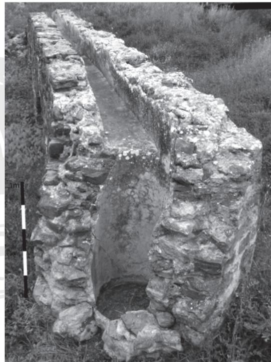
Fig. 10. Puits de rupture de pente en amont du pont Chorrera de l’aqueduc de Punta Paloma (cl. L. Borau).
