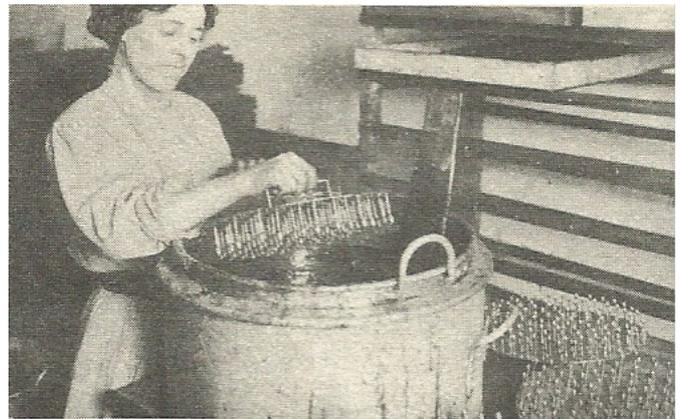
**Le remplissage :** après dessiccation à l'étuve les capsules sont placées dans un support en bois par pression.
