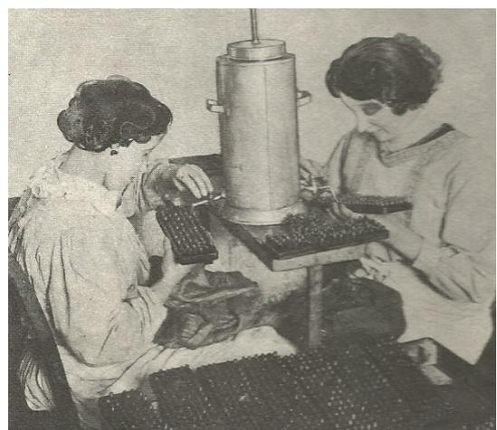
**L'occlusion :** soit les capsules sont fermées avec une goutte de solution gélatineuse chaude, soit le support est retourné dans la solution de gélatine. Elles sont une nouvelle fois étuvées, triées pour éliminer les capsules mal fermées et lavées (12).
