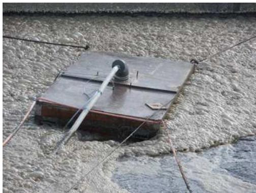
Figure 2 : Collecteur de gaz positionné sur un bassin aéré
