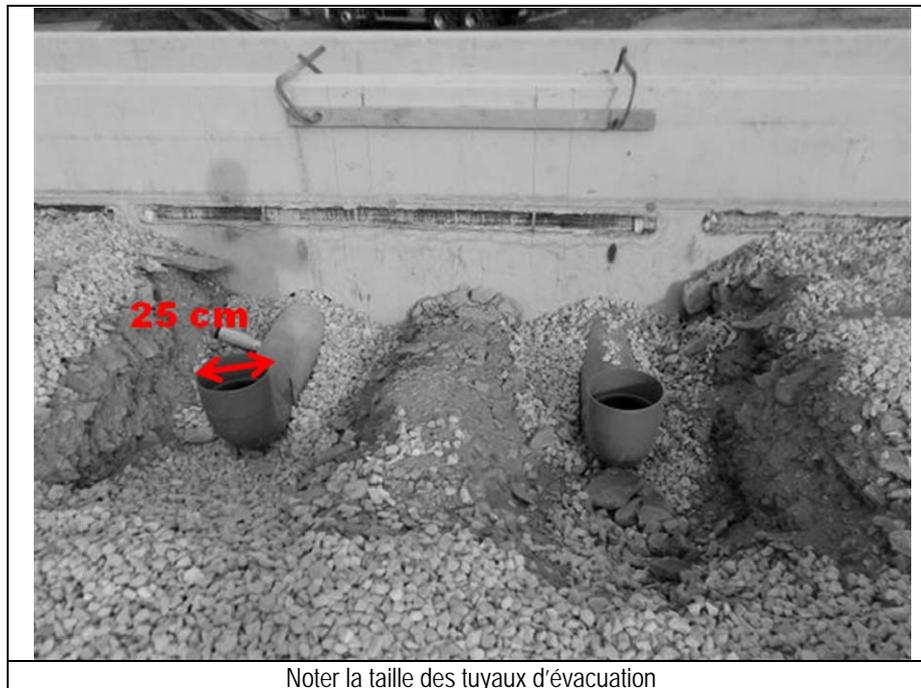
Figure 2 : Système de vidange des fosses à lisier
