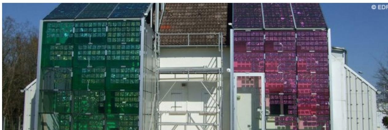
FIGURE 32 – Photographie représentant un bâtiment double-peau jouant sur la pigmentation des façades (Source : le moniteur)<sup>124</sup>
