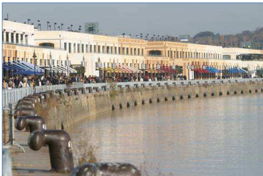
Figure 3: le quai des marques (photo : J.Cazzulo)
