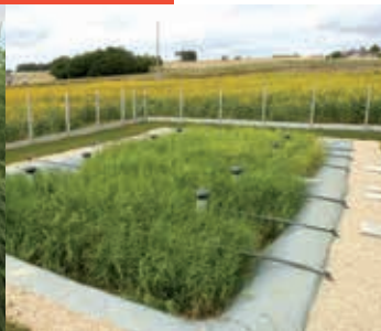
3. MISE EN PLACE DES ÉQUIPEMENTS
