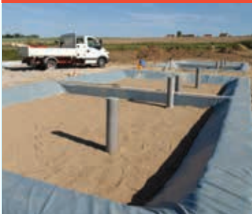
1. TERRASSEMENT DES BASSINS
