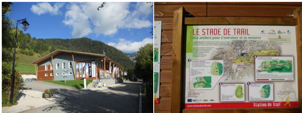
Le bâtiment de l'entreprise Raidlight à Saint-Pierre de Chartreuse (clichés A. Coste)
