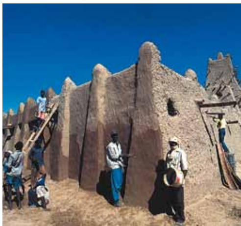
Formation de maçons, Tombouctou, Mali, 1996
