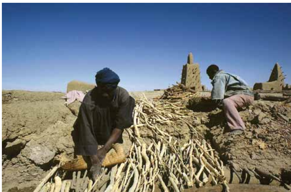
Formation de maçons, Tombouctou, Mali, 1996
