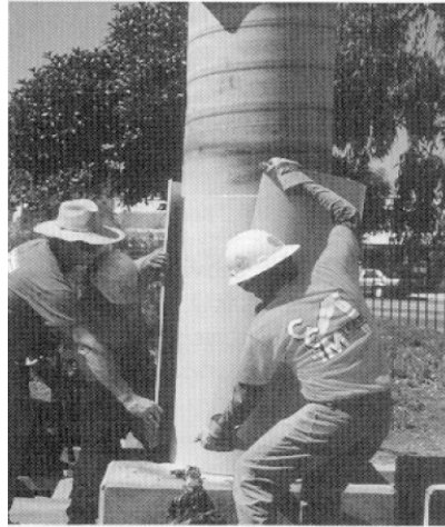
Figure I.3. 4: Chemisage par coquille préfabriquée en «PRF» (Monti 2003)
