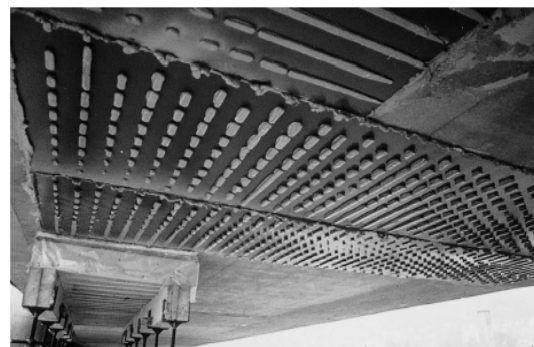
Figure I.1. 9: Tôles collées ; (a) difficulté de manutention ; (b) Renforcement du viaduc de Terrenoire par tôles collées perforées -Brevet Freyssinet- (Luyckx 1999)
