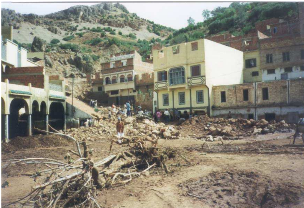
Photo 1. Vue vers le sud-est (6 août 1994). El Kebab au niveau d'Issighiden, le plus important torrent traversant l'agglomération. Le torrent est canalisé à partir de son entrée dans l'agglomération, mais le canal est peu entretenu. Les débordements provoqués par l'averse du 5 août 1994 ont causé des dégâts considérables. Au premier plan, la route est encombrée de matériaux divers. En arrière-plan, on observe le rebord du Causse d'El Kebab (cliché MD El Jihad).
