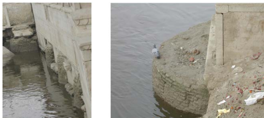
Figure 8 : Puits en maçonnerie soutenant les ghāt de Vrindavan, © S. Jalais
