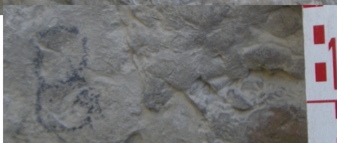
Graffitis sur la paroi « Vonnet » et « 8 ». Photo F. Guillot.
