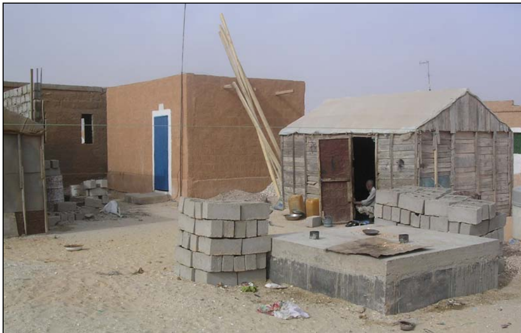
Photo 2 Exemple de module qui comporte une chambre, latrine (fosse au premier plan) et clôture. Les anciennes cabanes du bidonville constituent toujours un habitat d'appoint. (Cliché de l'auteur, 01/2004) Example of module : room, septic tank and fence. In front of it, the slum's cabin, still here.
