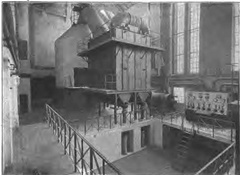
L'un des deux appareils vu complètement. De gauche à droite : la « tour », la chambre contenant deux séries de tuyaux-filtres, chaque série déversant sa poudre sur une vis sans fin. A droite le turbo-ventilateur et la table de manœuvre commune aux deux appareils.
