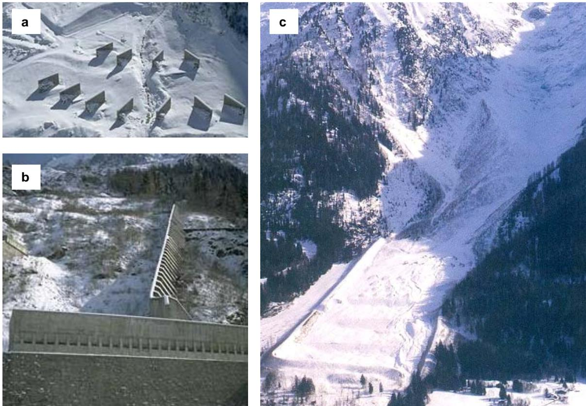
Figure 1.8 Ouvrages de freinage et d'arrêt : a. Dents défecteurs (photo par F.Valla) b. Digue en béton armé empêchant le débordement latéral de l'avalanche (photo par F.Rapin). c. Plage de réception de Taconnaz (Haute- Savoie).
