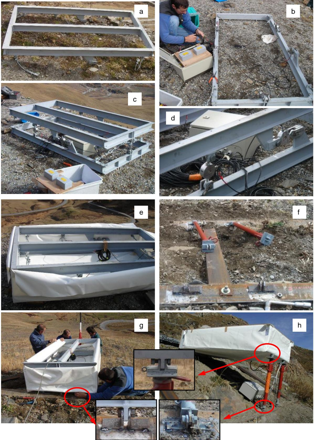
Figure 3.37 Installation de la plaque-captteur sur place : a). Bâti supérieur b). Bâti inférieur avec cinq capteurs de force c). Ensemble de la balance d). Capteurs de force installés dans la direction verticale et horizontale. e). Jupe de protection f). Pattes de fixation g). Fixation de la plaque h). Finalisation.
