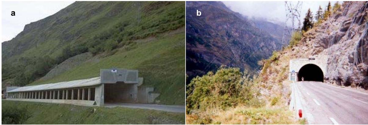
Figure 1.6 Ouvrages de déviation : a. Galerie paravalanche (photo par F.Rapin, Cemagref) b. Tunnel (Iseran).
