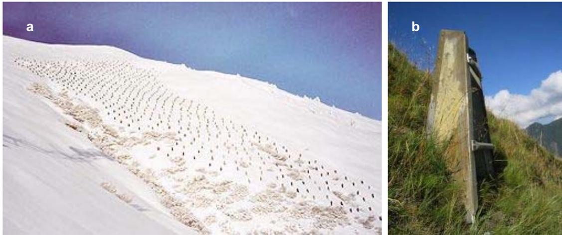
Figure 1.3 Ouvrages agissant sur la répartition de la neige : a. Snowgrippers en groupe [www.geo.fr] b. Snowgripper [www.snowgripper.at].
